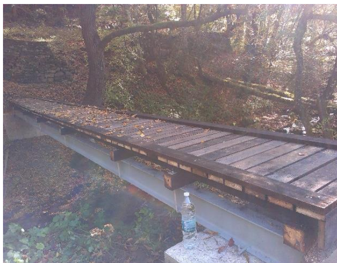
Фиг. 9.7.5. Завършен мост на ХГС №24
